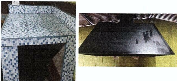
Reparación de área de cocina
