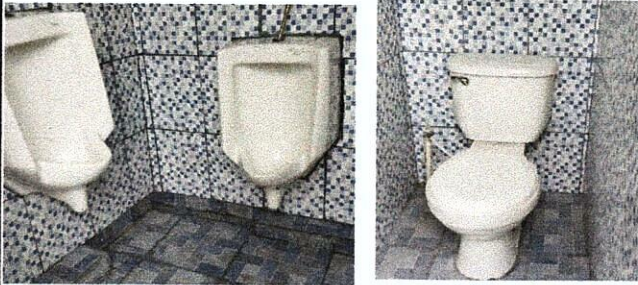
Reparación y sustitución de azulejos en baños
