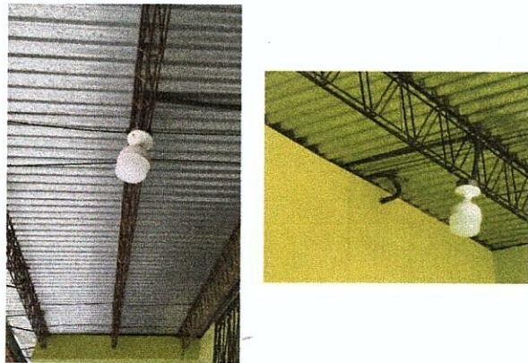
Reparación del sistema eléctrico
